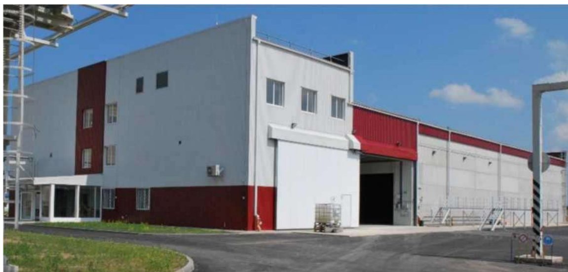
Рисунок 3.2-26. Здание накопительного хранилища ОВНН
