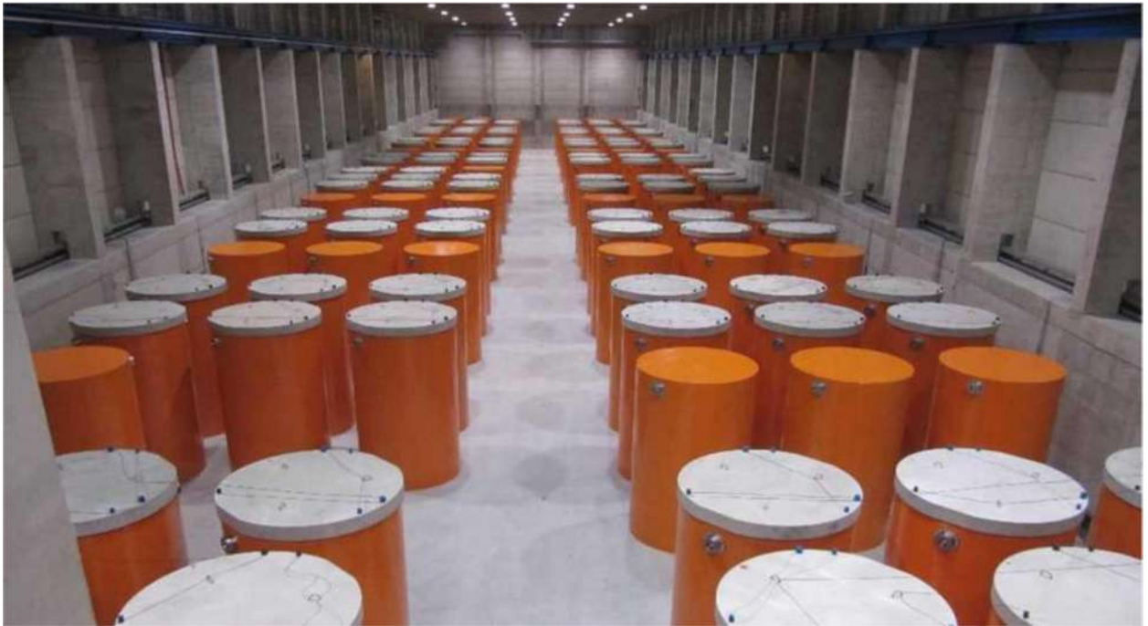
Рисунок 3.2-3. Зал хранения бочек ОЯТ в ВХОЯТ-2.
