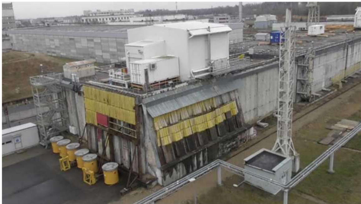
Рисунок 3.2-7. Сооружение хранилища ТРО на ИАЭС с группой G3 с блоком МО-3.
