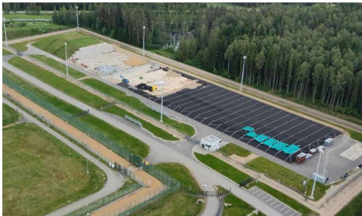
Рисунок 3.2-29. Модуль хранилища ОВНН с сформированными инженерными барьерами и защитной стеной после проведения отдельной кампании размещения
