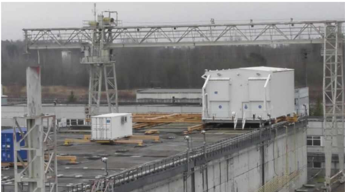
Рисунок 3.2-5. Здание хранилища саморазрушающихся стальных рельсов № 157/1 на АЭС ИНП с группами саморазрушающихся стальных рельсов G1 и G2. Извлекательный блок МО-2.
