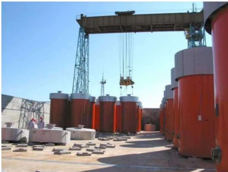
Рисунок 3.2-1. Хранилище отработанного ядерного топлива ISFSF-1 с контейнерами.
