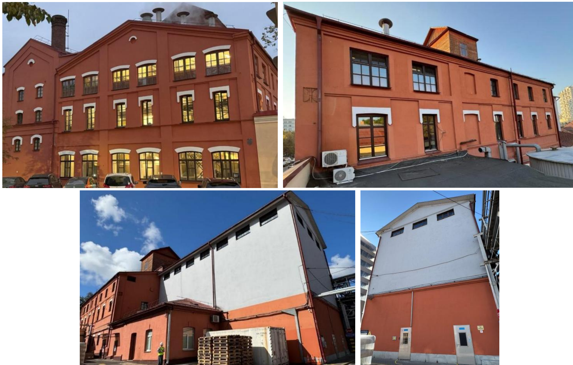
Рисунок 5 – Главный корпус (варочный участок, химводоочистка) (инв. № 500/С-1563). Виды 1-4
